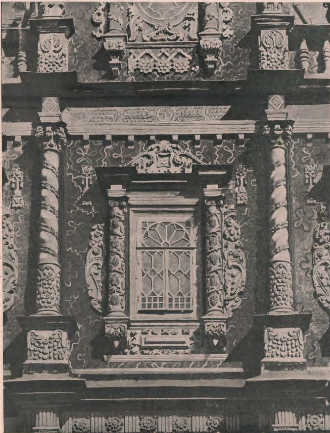
37. Белокаменная резьба на южной стене «Строгановской» церкви в гор. Горьком. 1702 — 1719 гг.
